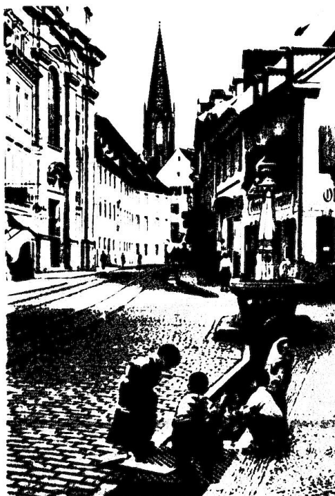
Vertoldstraße mit Stadt baule. Bahnbahn mit Mopf steinpflaster, Schweg mit Rheinsteinpflaster
