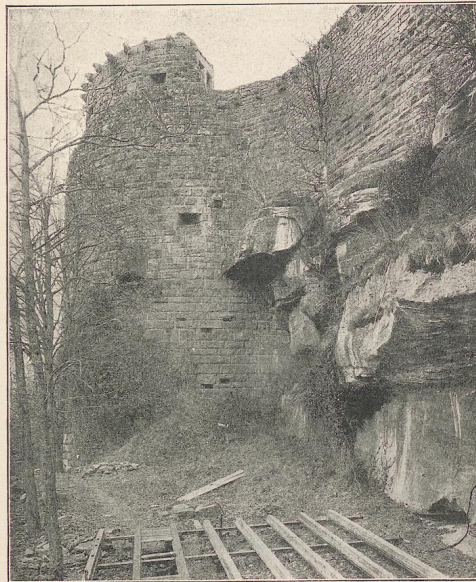
Abb. 33. Hohkönigsburg, Südlicher Turm des großen Bollwerks.
