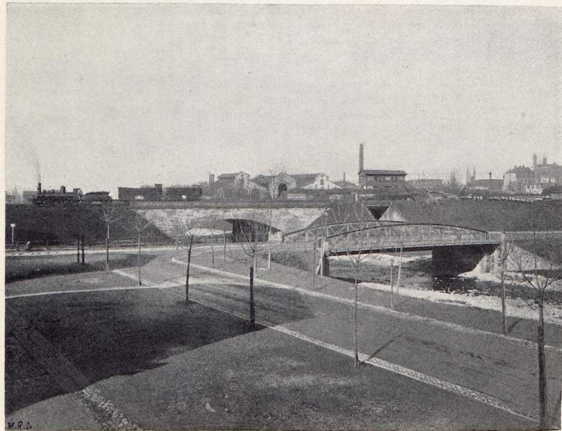
Die Freiau- und Eisenbahnbrücke.
