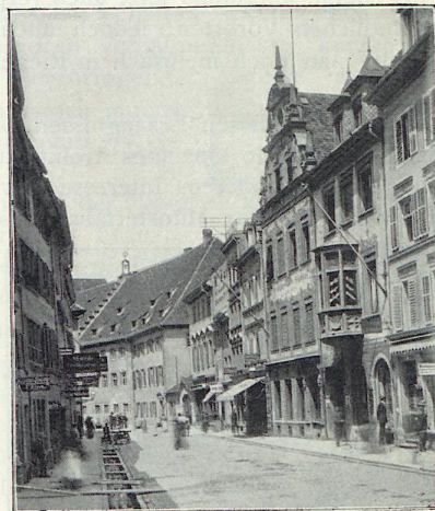
Häuserflucht in der Bertholdstrasse.
