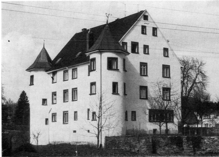
Restauriertes Steinemer »Schlößli« (Aufnahme Fritz Schülin, 1974)
