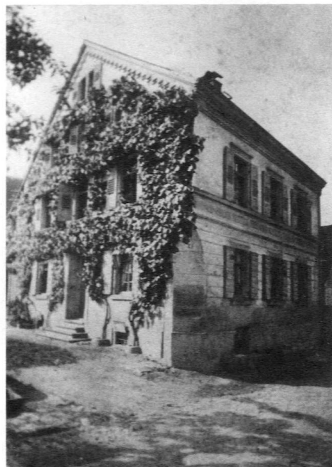
Müllheim, Kirchgasse 6, abgebrochen
