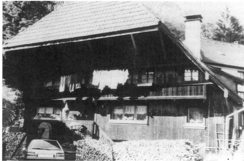
Abb. 3: Die Felsenmühle, ursprünglich eine Erz-, später eine Getreidemühle, dient heute nur noch Wohnzwecken. (Foto: J.-W. Schindler)
