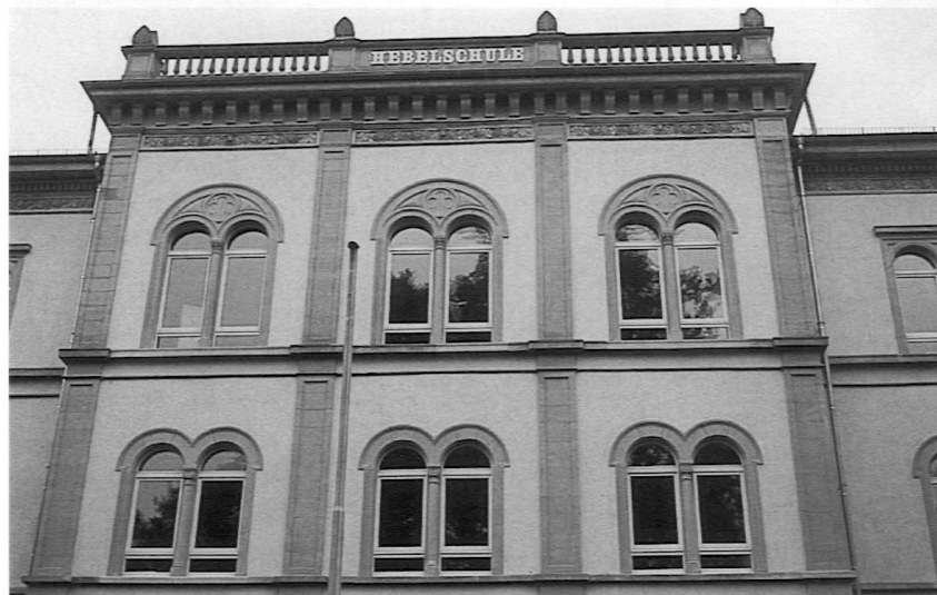
Abb. 2: Lörrach, Hebelschule, Mittelrisalit
