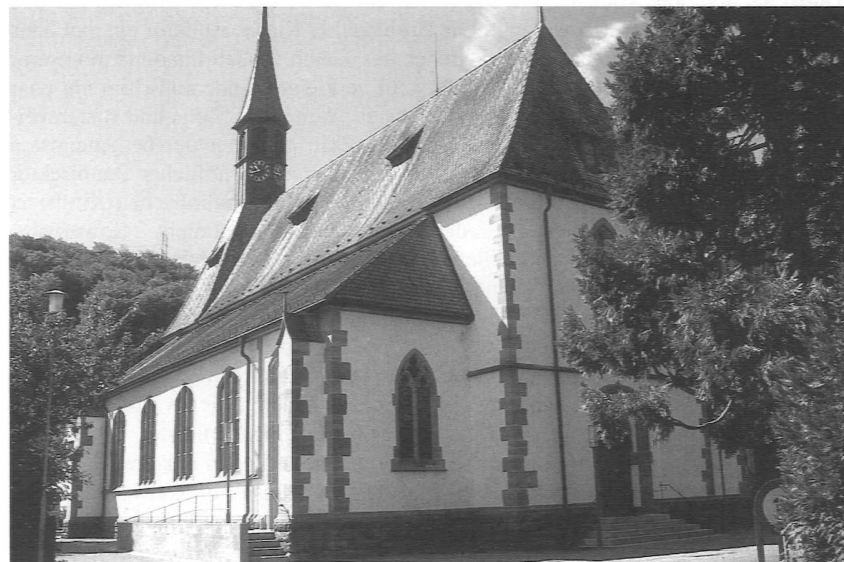
Abb. 6: Katholische Kirche von 1900. Späte Neugotik, die historische Anregungen, hier auch regional typische, frei verarbeitete
