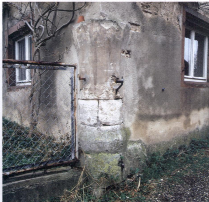
Abb. 6: Der kleinere der beiden achteckigen Pfeiler an den Ecken der westlichen Giebelwand des Kernbaus. Beide trugen ehemals auskragende Erker. Foto: LDA, Paul Mitchell 1994
