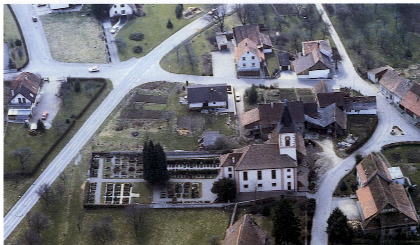
Abb. 1: Wittlingen, Luftbild vom 1.04.1987, Kirche St. Michael von Norden. Unmittelbar südlich der Kirche von 1774, teilweise durch ihren Turm verdeckt, das Gelände der ehemaligen Tiefburg. Mauerreste des Wohnturms stecken noch in der neuzeitlichen Hofanlage. (Foto: Gensheimer, Landesdenkmalamt Baden-Württemberg, Außenstelle Freiburg, Archäologie des Mittelalters, Nr. 8310/11-3)
