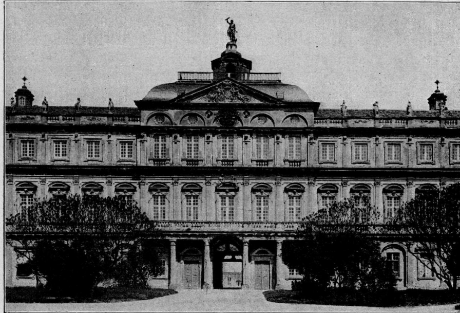
Abb. 1. Mittelbau von der Ehrenhoffseite.
