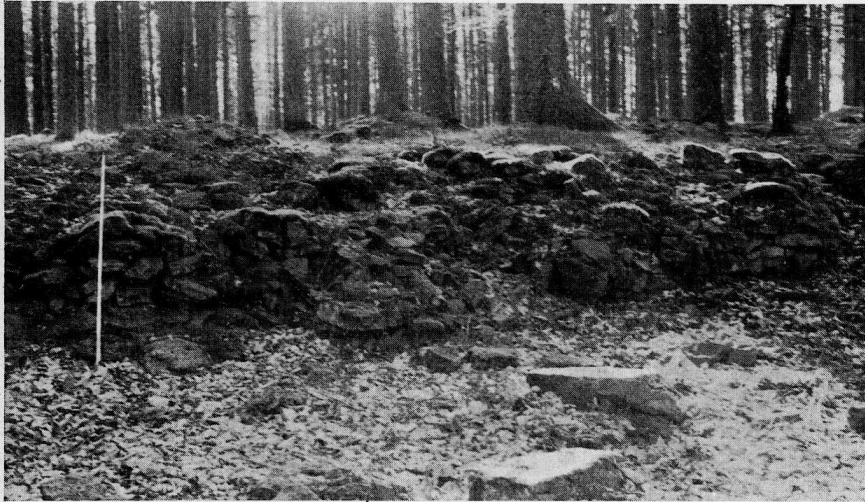
Abb. 7. Battert bei Baden-Baden. Außenfront der Mauer auf der Offseite des Walles bei Punkt 6 des Planes (Abb. 5). Länge des Maßstabes 1 m.
