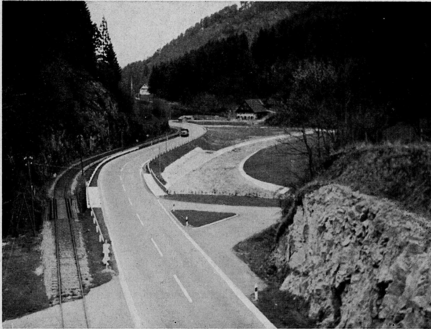
Im Schiltachtal. Blick talabwärts von der Brücke über den Straßendurchstich beim Deisenbauernhof. Rechts vor dem Felsen noch ein Stück der alten Talstraße, die in scharfem Bogen um die dortige Bergnase herumführte.
