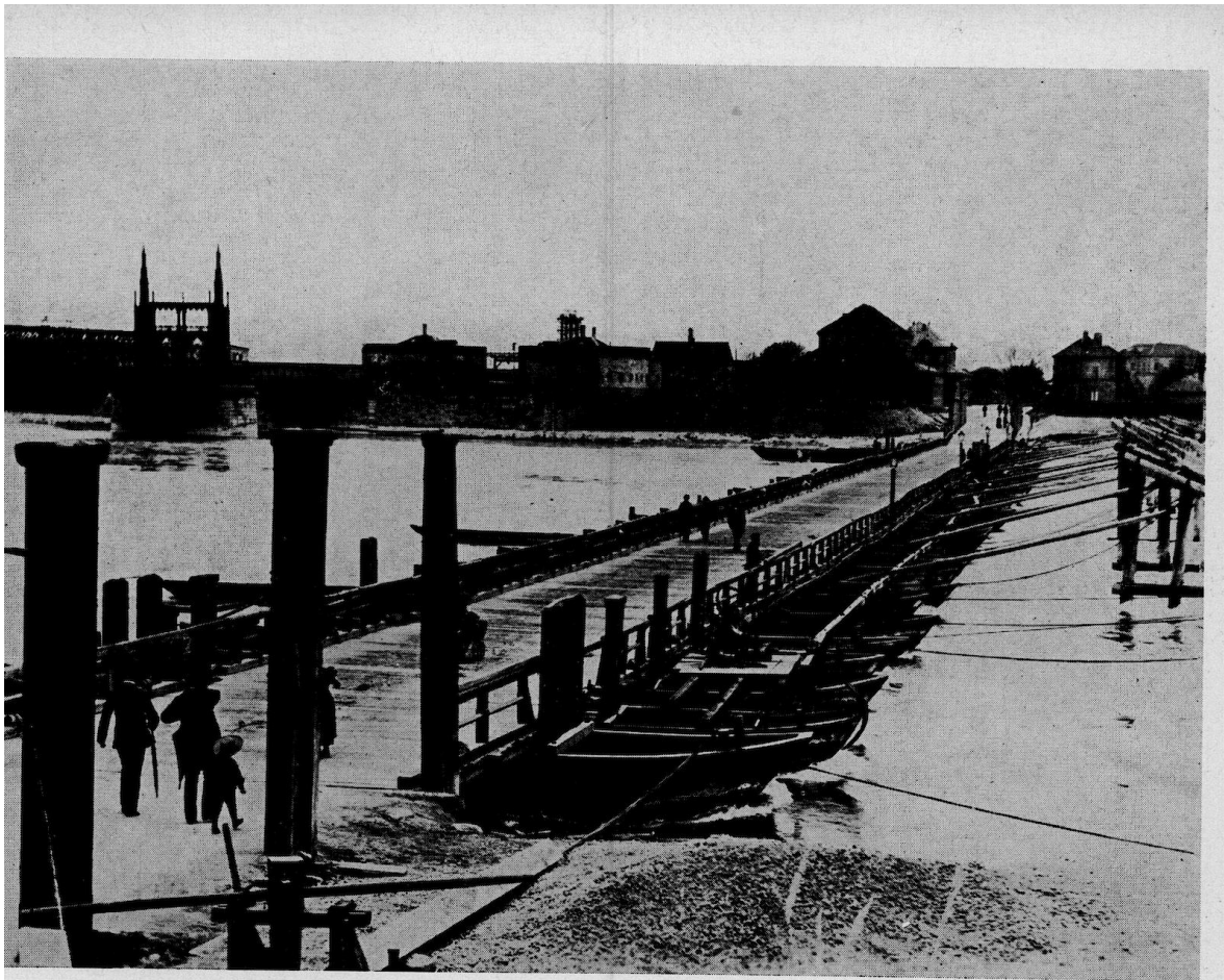
Die Schiffsbrücke des 19. Jahrhunderts; die Pontons sind durch Anker und durch Seile festgehalten und untereinander verbunden; links die Eisenbahnbrücke (1861). Blick auf die Kehler Seite; starke, gemauerte Uferbefestigung. Klischee: Stadtverwaltung Kehl
