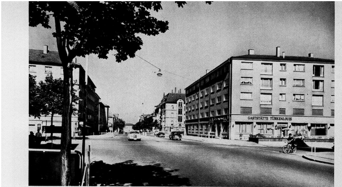
Die wiederaufgebaute Bahnhofstraße von Rastatt.
