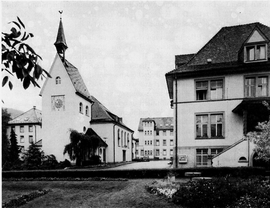
Rechts: Verwaltungsgebäude. Im Hintergrund: Frauen-Altbau. Links neben der Kapelle: Frauen-Neubau.
