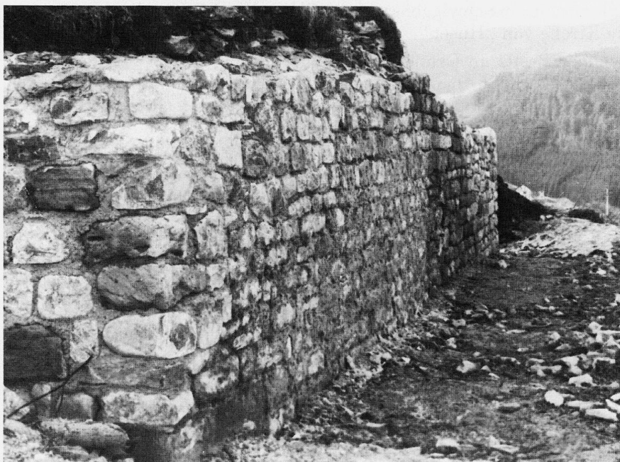
Freigelegtes Stück des Bergfrieds, Nordseite. 11. Jahrhundert. Nach umfangreichen freiwilligen Arbeitseinsätzen wurden die Umfassungsmauern des „Schlöble“ freigelegt und ausgebessert.
