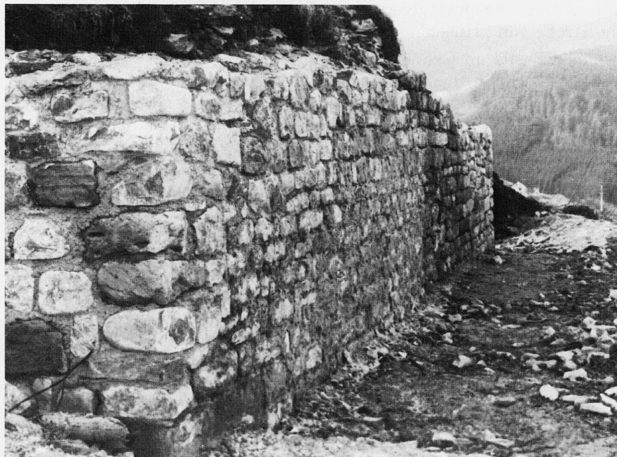
Freigelegtes Stück des Bergfrieds, Nordseite. 11. Jahrhundert. Nach umfangreichen freiwilligen Arbeitseinsätzen wurden die Umfassungsmauern des „Schlöble“ freigelegt und ausgebessert.
