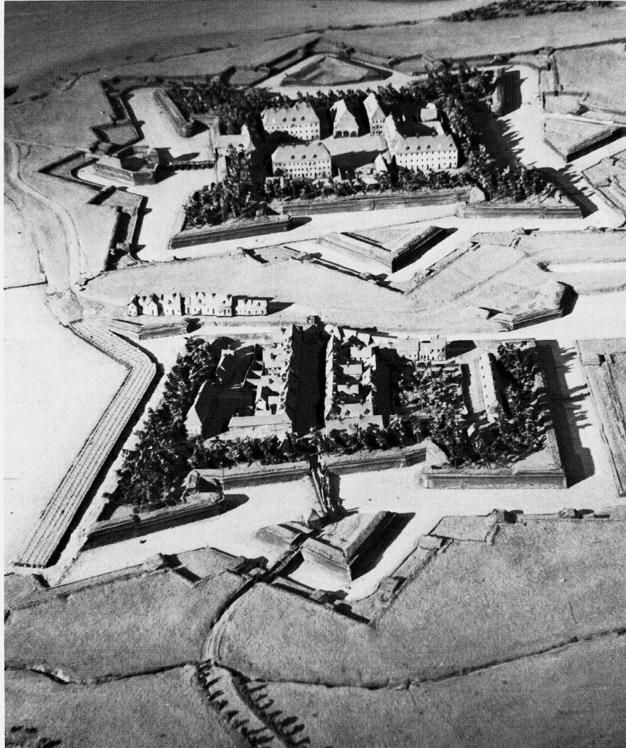
Das Kehler Hornwerk von Südosten gesehen. Modell von 1727. Historisches Museum Strassburg. Blick in die Hauptstraße, auf den Kurtinenwall und den Wassergraben mit Brücke. Vorn der Halbmond mit dem Weg nach Sundheim, rechts die Bastionen des Hornwerks. Die Stelle des Hornwerks nimmt etwa heute der Marktplatz ein. Oben die Hauptfestung, darin links das Festungstor zur Rheinbrücke (heute etwa bei der Eisenbahnüberführung über die Hafestraße), rechts der Gebäudekomplex des „Gouvernements“ mit der von Beaumarchais 1780 gegründeten Druckerei der Société typographique et littéraire, die bis 1790 bestand. Dazwischen lag (fehlt auf diesem Modell) die Kirche.
