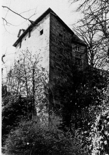
Schloß Staufenberg: Der Flankierungsturm (F).
