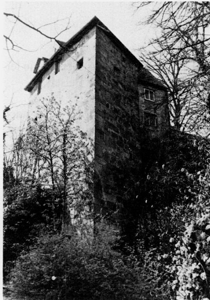
Schloß Staufenberg: Der Flankierungsturm (F).
