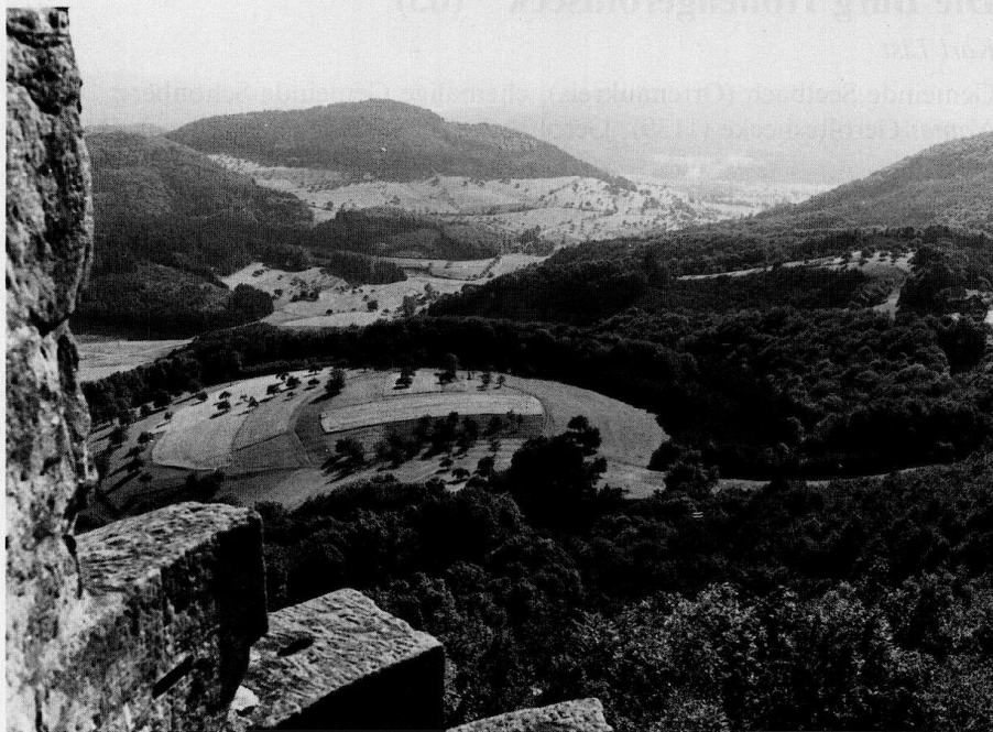
Die Hohengeroldseck: Blick vom Treppenturm des Palas nach Westen.
