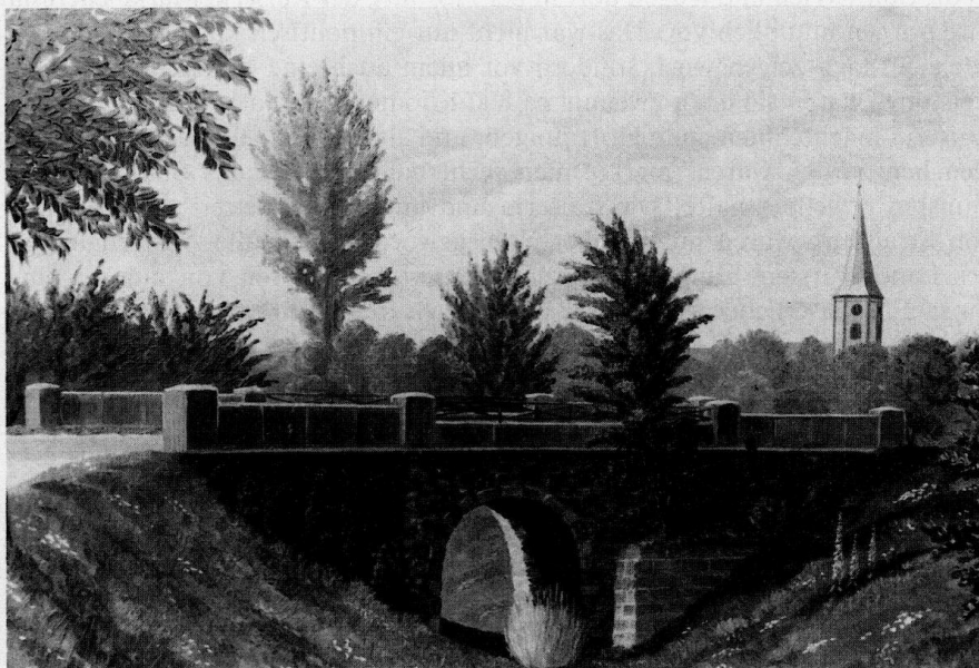
Die Kanalbrücke an der B 36 südlich Freistett (nach einem Gemälde) Aufnahme: Hermann Kiefer
