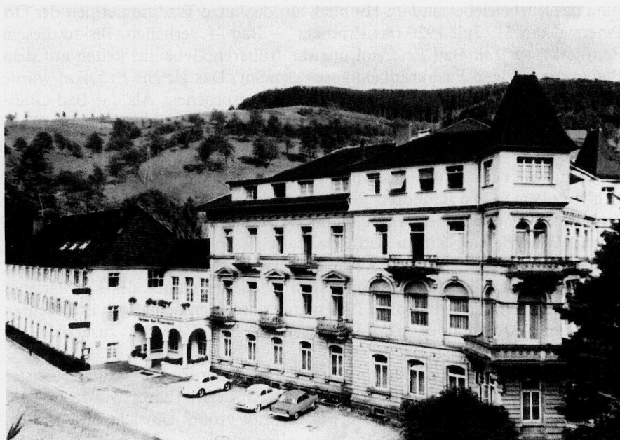
Kurhaus Bad Freyersbach vor dem Abbruch
