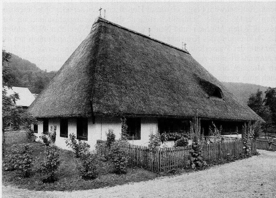
Das Hotzenwaldhaus als Nachbau im Museum
