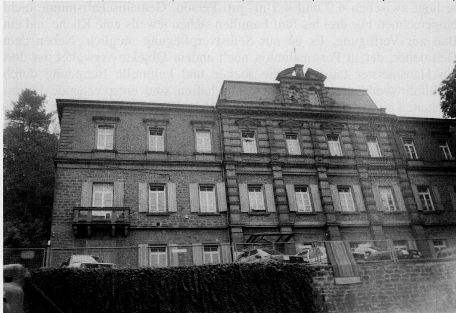
Staatl. Übergangswohnheim des Ortenaukreises in Lahr, Altvaterstraße mit rund 100 Plätzen
