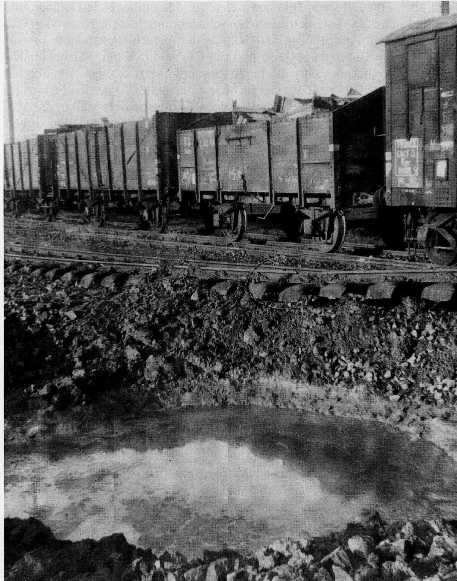
Zerstörungen durch Luftangriffe auf dem Offenburger Güterbahnhof 1944. Foto: Stadtarchiv Offenburg
