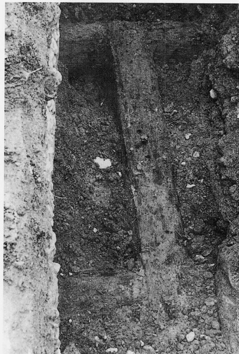
Abb. 27: Balkenrost vom Lager einer ehemaligen Unditzbrücke. Über sie führte der Weg von der Burg Mahlberg zu den Fahrackern bei der Wüstung Trisloch am Rhein.
