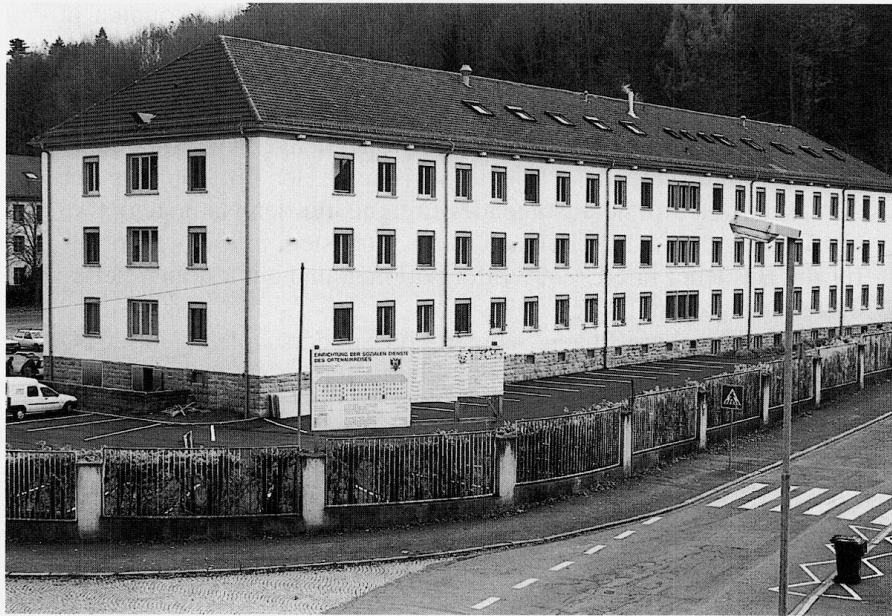
Außenstellen-Gebäude in Lahr, Langemarckstraße 11
