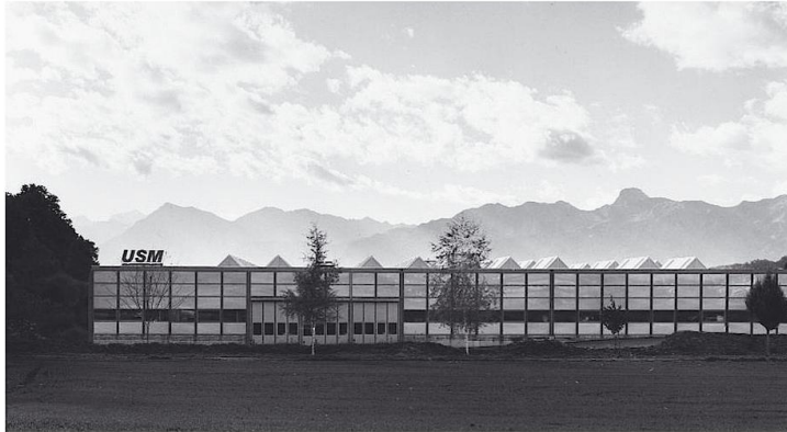
USM-Betriebsanlage in Münsingen. (Foto: USM)
