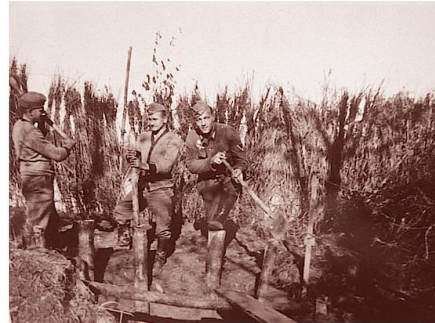
Tarn- und Sicherungsarbeiten
