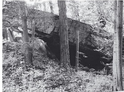
Gesprengter Bunker beim „Schlössle“, Waltersweier
