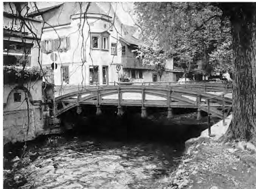
Abb. 4 Ansicht der Brücke
