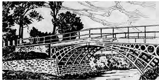
Abb. 8 Brücke über das Striegauer Wasser bei Laasan
