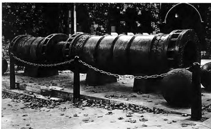
Abb. 2 (Nach D. Pope, Guns) Dardanellengeschütz im Tower zu London. 1464. Bronze. Gewicht: 18\frac{3}{4} to; Länge: 3,40 m; Kaliber: 66 cm; Geschößgewicht: 720 Pfund
