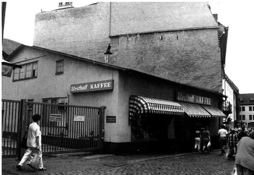
Abb. 7 Laden der Firma Westhoff in einem ehemaligen Behelfsbau der Nachkriegszeit an der Eisenstraße (Photo des Autors)
