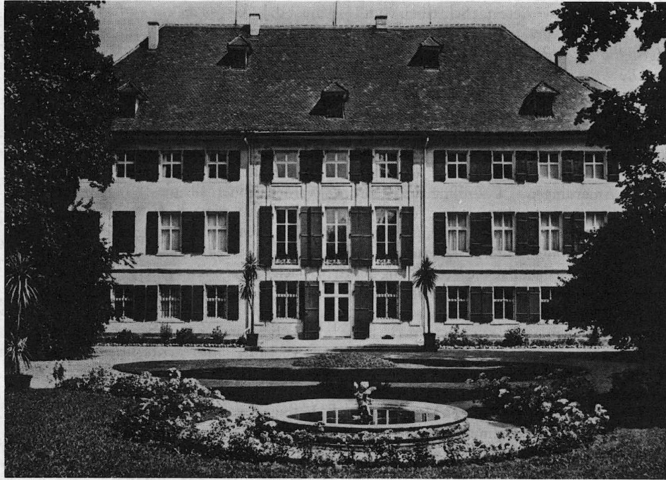
Schloß Amerdingen bei Nördlingen. Nach 1833 wurde hier das Familienarchiv aufbewahrt. Vorlage: Foto Hirsch, Nördlingen
