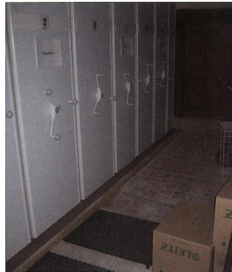
Unter der Fahrregalanlage in der ehemaligen Schlossküche im Untergeschoss erkennt man am Keil der Holzbodenkonstruktion die historische Abwasserrinne und den alten Fliesenboden. FOTO: Georg Loges
