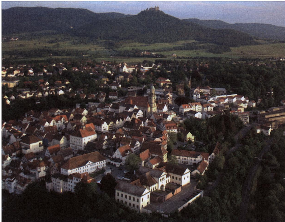
Hechingen aus der Vogelperspektive von Norden mit der Burg Hohenzollern im Hintergrund. Der oval angelegte mittelalterliche Stadtkern ist gut zu erkennen, im Bildvordergrund der Schloßplatz mit dem Alten und dem Neuen Schloss (Bild: Jochen Speidel, Hechingen).
