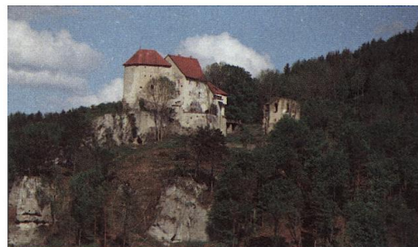
Nach einem großflächigem Holzeinschlag im Jahre 2008 ist die Burg Straßberg mit der zugehörigen Kirchenruine wieder vom Dorfe aus sichtbar.
